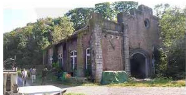
第2発電所は900kwの出力を持ち、大正時代に設けられた発電所である。発電所そばには網の置き場がある。ただ、この発電所には水の出口が見当たらなかった。建物側壁はレンガなのに、屋根はトタンぶきの木造屋根である。屋根まで立派にするお金がなかったと思いきや、長谷川技術士いわく、爆発があった場合に、圧力が屋根を通じて逃げるようにするためであって、その際、側壁がくずれないようにしているのだという。
