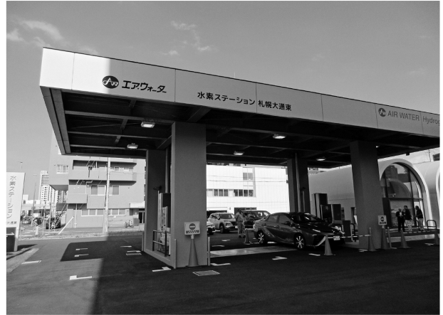
写真-5 市道への爆風を防ぐ壁の機能も兼ねる太い柱、奥には市道が見えます
