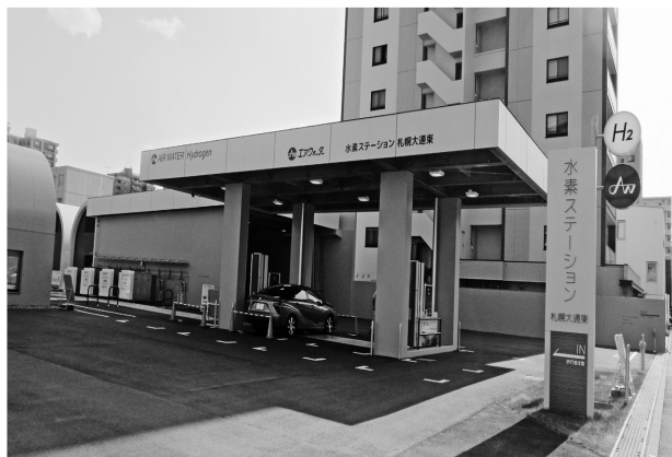
写真-1 エア・ウォーター水素ステーション札幌大通東
