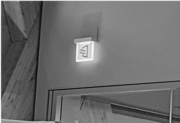
写真-5 外気を取り入れ推進の視覚設備
