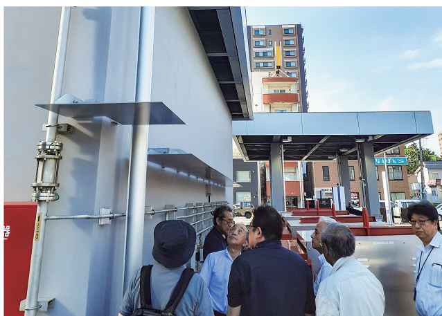
写真-2. 受入用配管上に設けられた雪除け用の「庇」について説明を受ける参加者の面々
