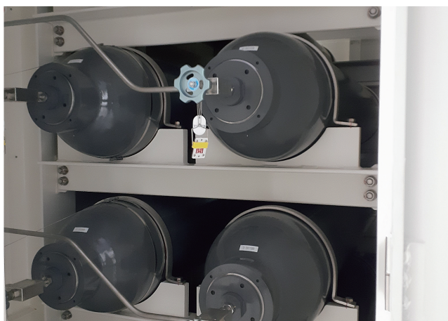
写真-3. まるで「魚雷」です、日本製鋼所 M&E 社製の水素蓄圧器( \phi=406.4\text{mm} 、 L=4364\text{mm} )
