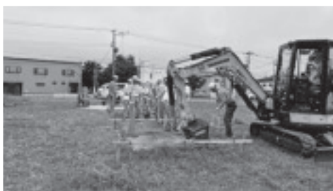
写真-5 機械を使用した掘削作業
