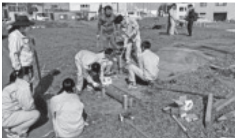
写真-8 階段を施工する生徒たち
