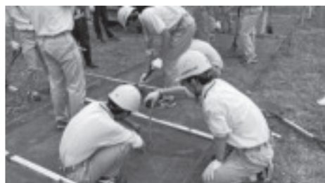
写真-6 丁張を活用したダスト舗装仕上げ作業
