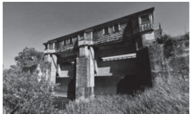
写真-8 釧路川「岩保木水門」
