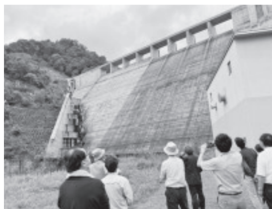
【夕張スーパーダム】
