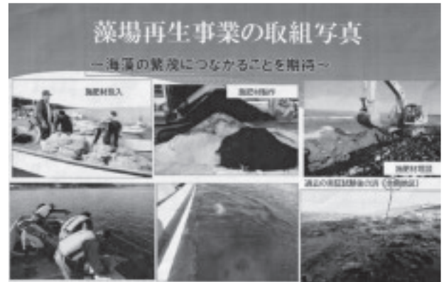
図-4 藻場再生事業施工状況
