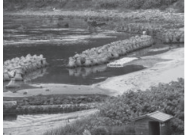
写真-10 照岸海岸の藻場再生の現況写真 (2023年10月施工)
