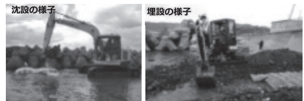
写真-4 ビバリーユニットの施工状況写真
