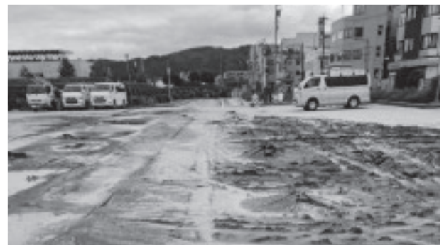
写真-14 被災状況 2(噴砂の様子)
