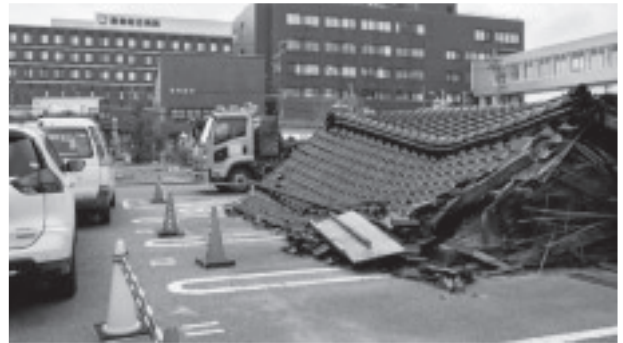
写真-7 恵寿総合病院と倒壊家屋の様子
