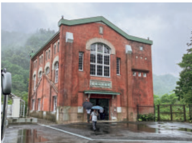
旧滝の上発電所
