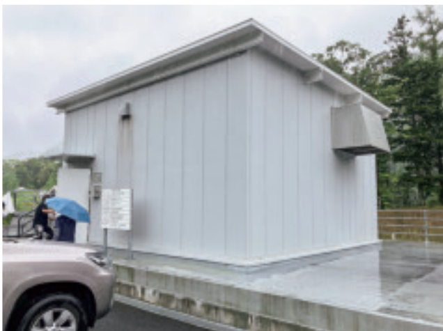
滝の上発電所
