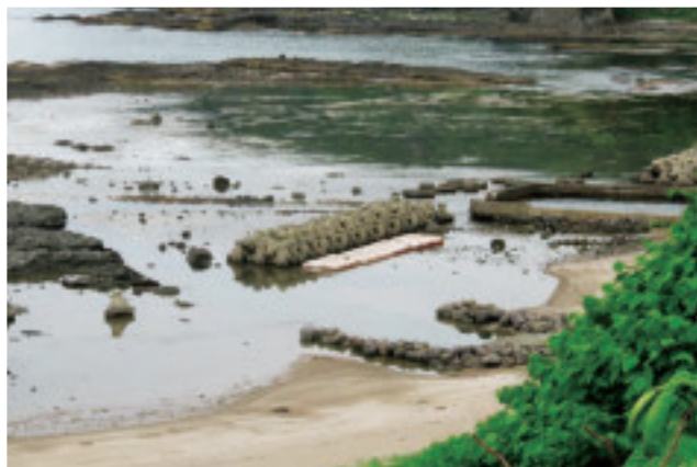
写真-4 古宇郡泊村照岸海岸の遠景(写真中央部がビバリーユニット 2022年10月施工)
