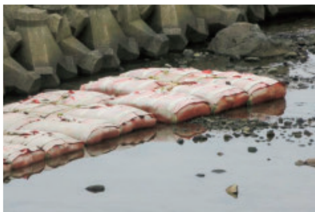
写真-5 古宇郡泊村照岸海岸のビバリーユニット施工箇所(2022年10月施工)
