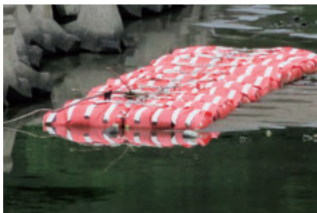
写真-6 古宇郡泊村照岸海岸ビバリーユニット施工箇所(2023年10月施工)
