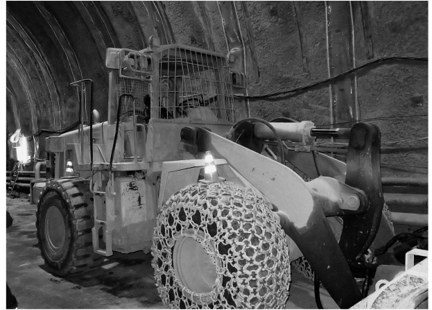
写真-10 札幌トンネルで使用されている重機
