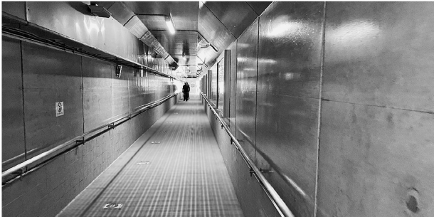
写真-6 ダム堤体内(多目的エレベーター通路)
