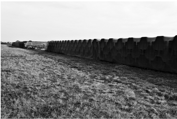
写真-1 鋼矢板の備蓄状況
