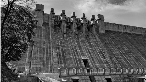
写真-5 下流苑池よりダム放流施設を望む
