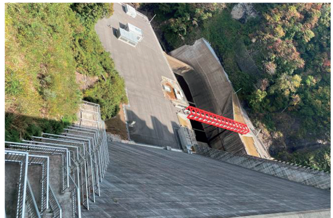
堤体天端より下流苑地を覗き込む。堤体の端部(写真左)に 管理用の階段。苑地奥の建物は「群馬県 ハッ場発電所」
