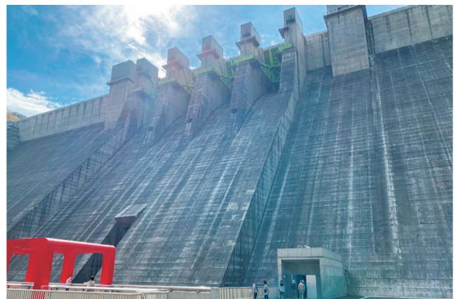
下流苑地よりダム堤体を見上げる。人が見えるのが「多目的 エレベーター」入り口。写真左に管理橋「ハッ場もみじ橋」
