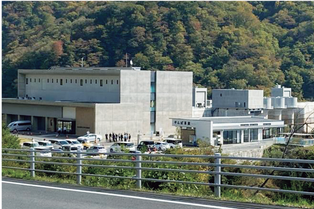
〈群馬県吾妻郡長野原町〉国土交通省 ハッ場(やんば)ダム管理支所(なるほど!やんば資料館)の全景。飲食施設が隣接
