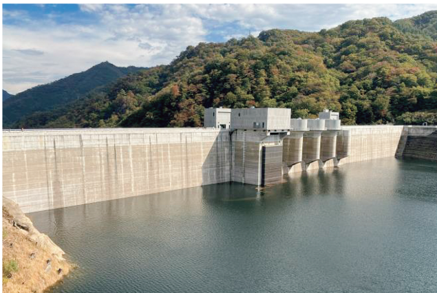
展望デッキよりダム堤体と「ハッ場あがつま湖」を望む。 中央部に連続サイフォン式取水設備(任意の位置から取水可能)
