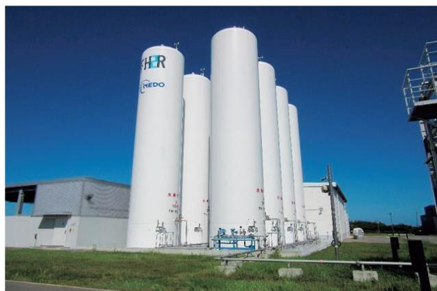
写真-5 水素貯蔵タンク(ガスホルダー)
