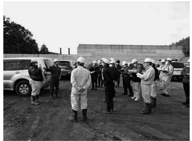
写真-4 砂防堰堤【緊急+恒久対策】(東和川)
