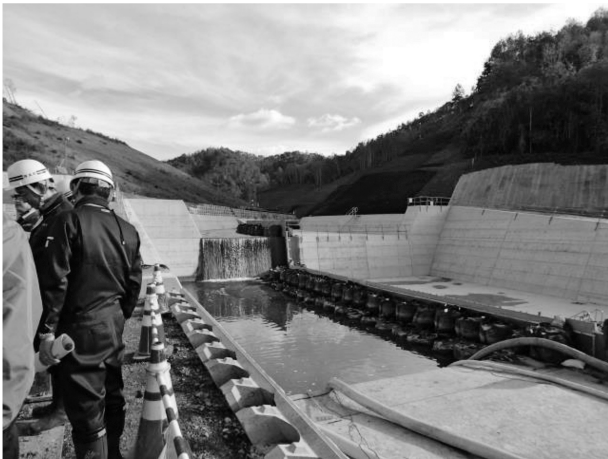
写真-2 溪流保全工【恒久対策】(日高幌内川)
