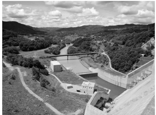
写真-3 堤体下流を望む
