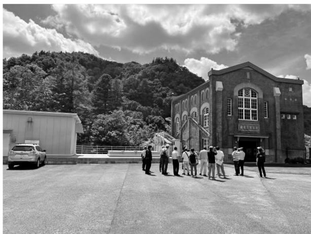
写真-4 新・旧滝の上発電所
