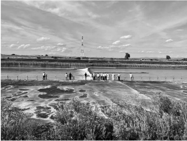
写真-7 清幌床止(1段目)
