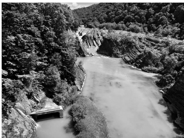
写真-5 滝の上発電所放水口と千鳥ヶ滝
