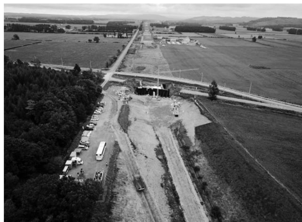
【振別南道路改良工事現場】
