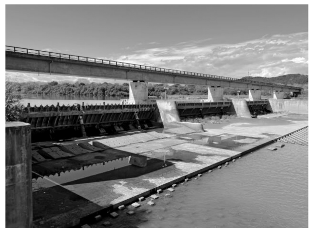
【千代田新水路分岐堰】
