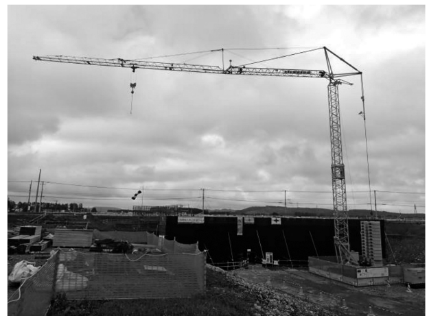
【定置式水平ジブクレーン】
