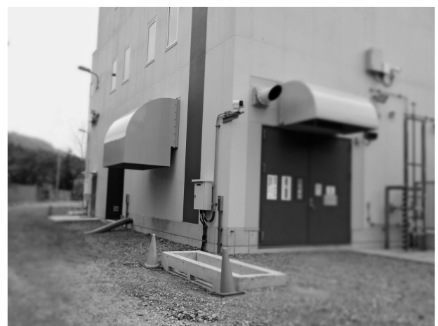
写真-15 鬼首地熱発電所の発電建屋の状況
