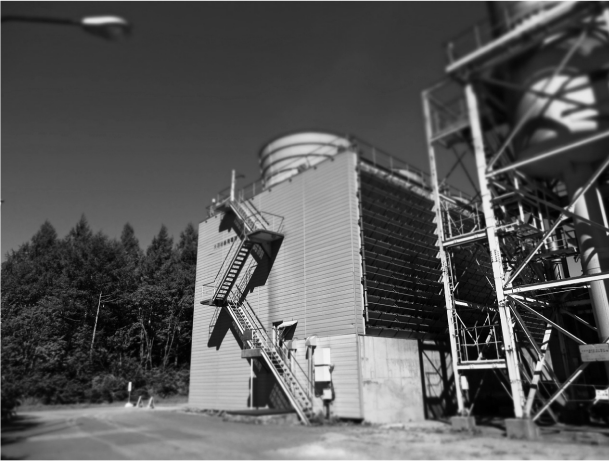
写真-3 大沼地熱発電所の発電所建屋等の外観
