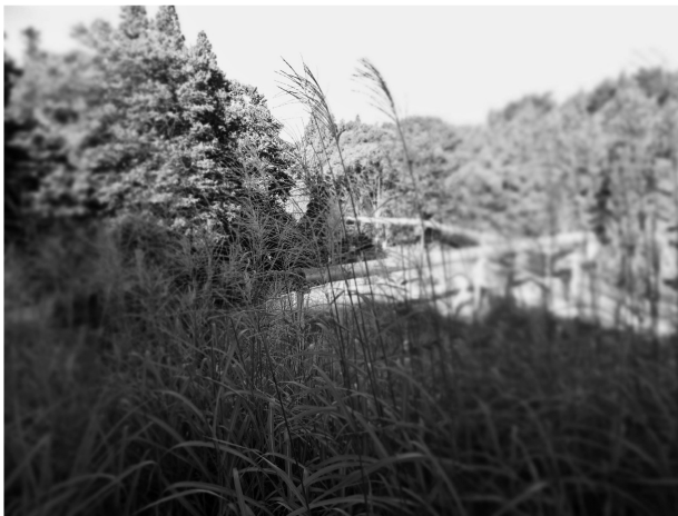
写真-10 上の岱地熱発電所の生産井等の外観
