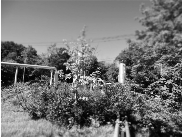
写真-5 大沼地熱発電所の生産井等の外観
