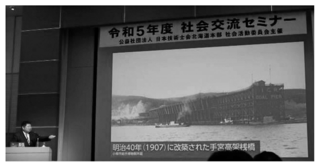
写真-5 明治40年に改築された手宮高架棧橋
