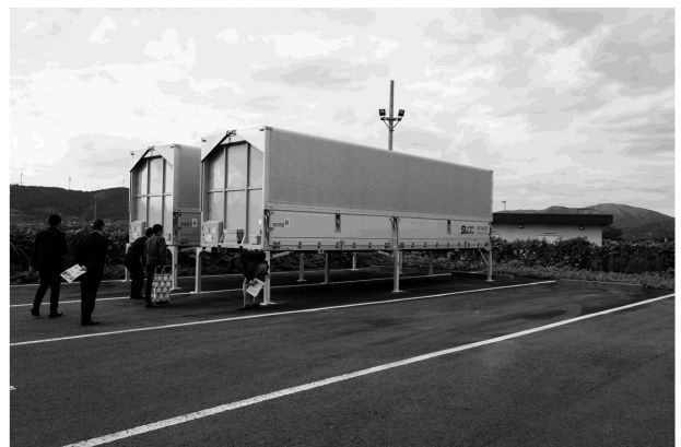
写真-11 トラック荷台中継設備
