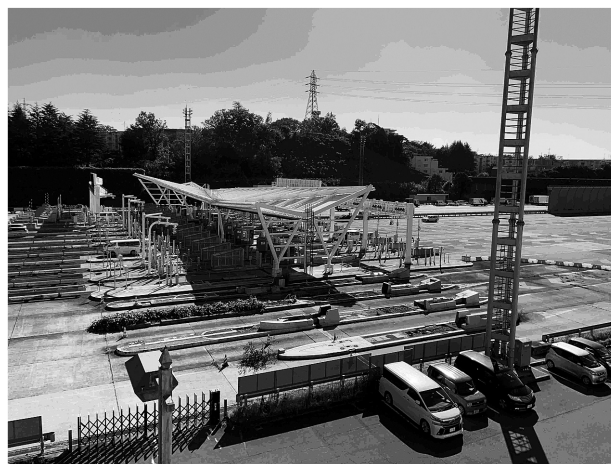
写真-2 管制センター屋上から望む東京料金所
