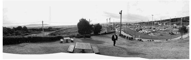
写真-4 駿河湾沼津 SA の防災ヘリポート(左奥)
