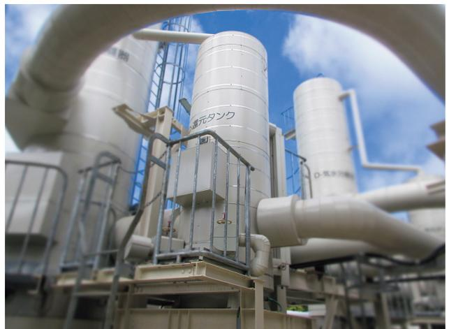
写真-12 鬼首地熱発電所の蒸気分離塔等の外観
