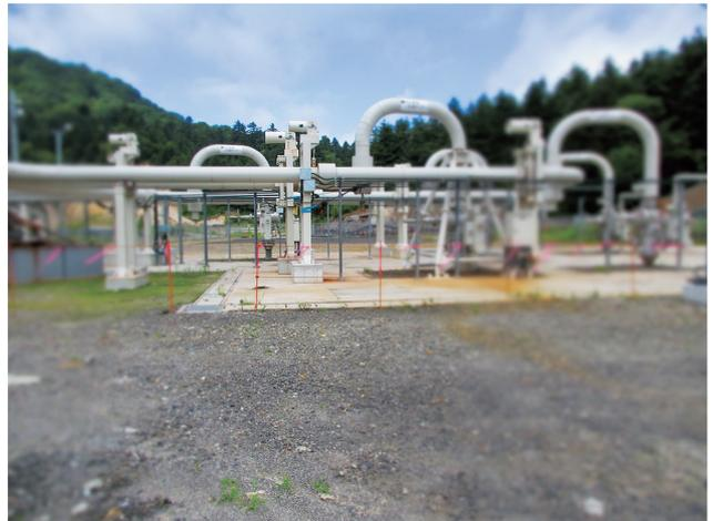
写真-11 鬼首地熱発電所の集中型生産井外観
