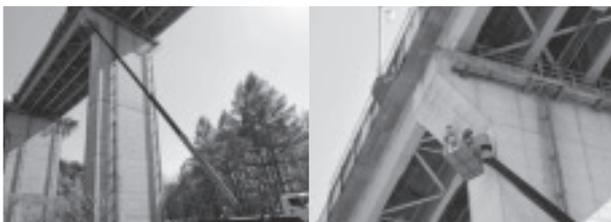
写真-5 高所作業車(30m級)
