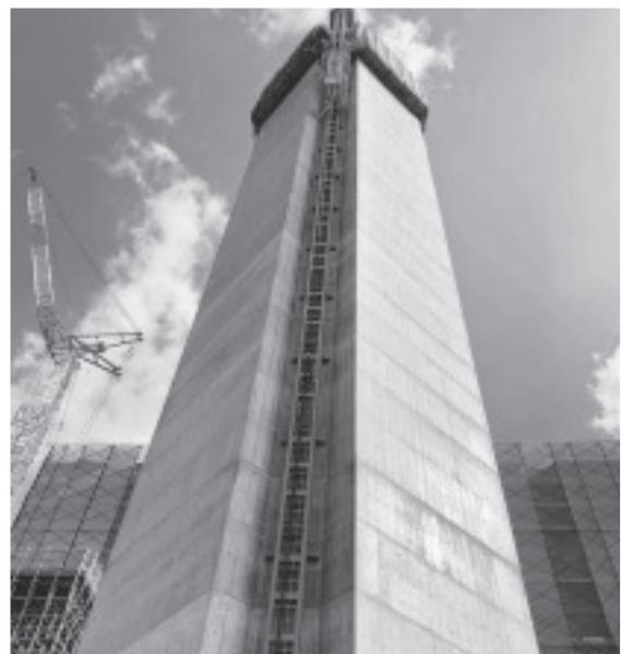
写真-6 煙突の建設状況
