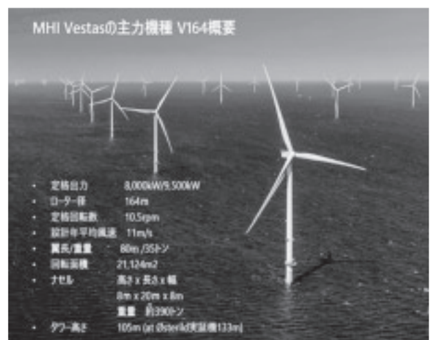
図-4 MHI Vestas 社の主力機 V164 の概要
