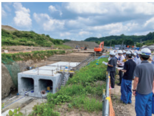
白川浄水場の取水渠の建設状況
