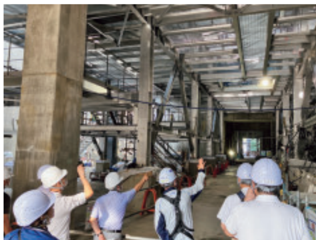
駒岡清掃工場(建屋内部)の建設状況
