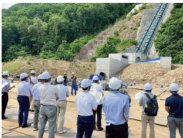
白川浄水場の接合井・斜面管路前での説明状況
