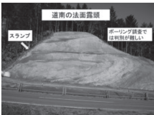
図-4 道南の道路切土斜面
