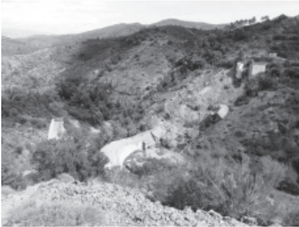
図-8 マルパッセダム(アーチ式)の残骸
