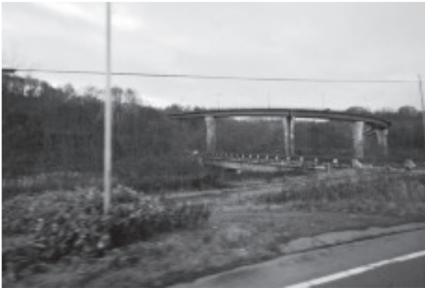
図-8 歌志内市に架かる「かもい大橋」
