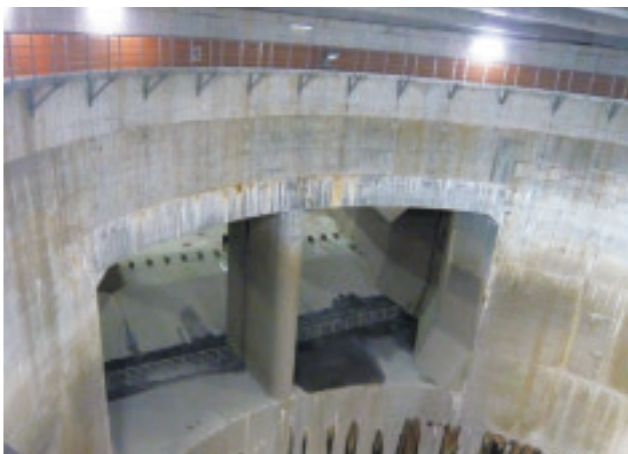
写真-8 第1立坑上部のキャットウォーク
