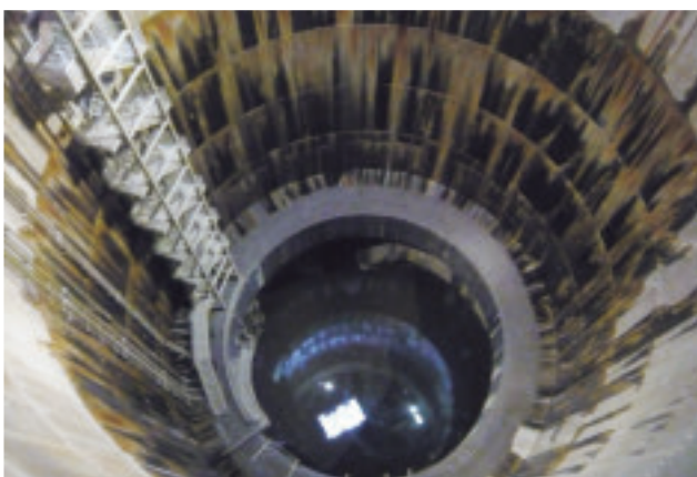
写真-9 キャットウォークから第1立坑を望む
