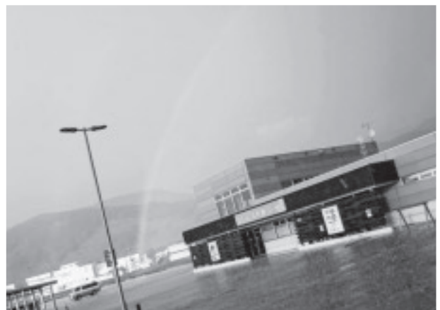
写真-2 管理棟 外観
