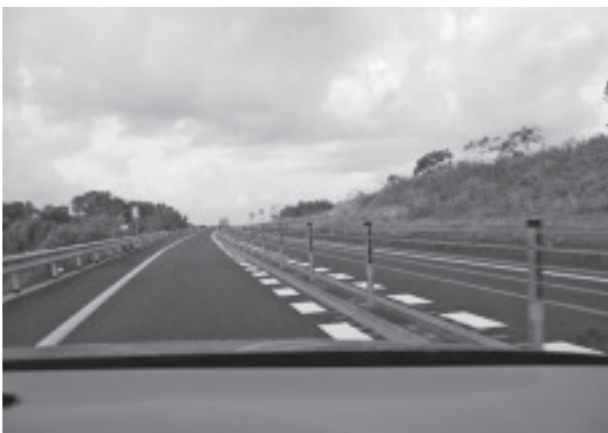
図-3 東九州自動車道暫定 2 車線区間
