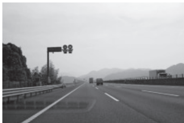
図-1 新東名(片側3車線、120キロ規制区間)
