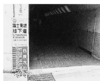
危険水位を示した地下道
