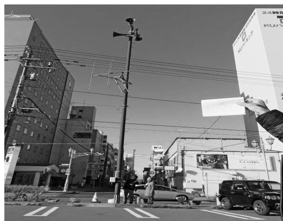
「安全モノ」・防災無線(スピーカー)
