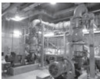
写真-3 導水ポンプ室
