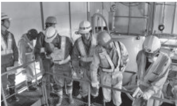
写真-3 排水処理施設
