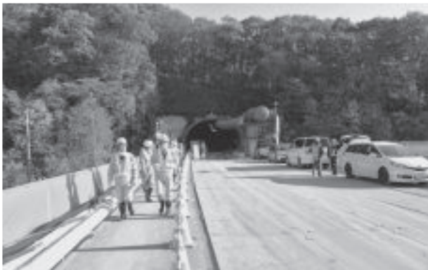
写真-2 坑口 土被り
