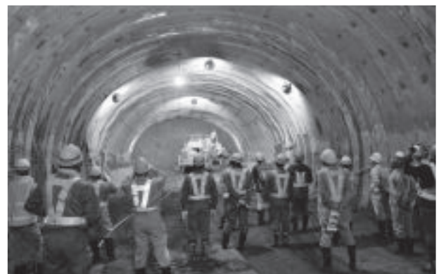
写真-1 先端部 掘削状況
