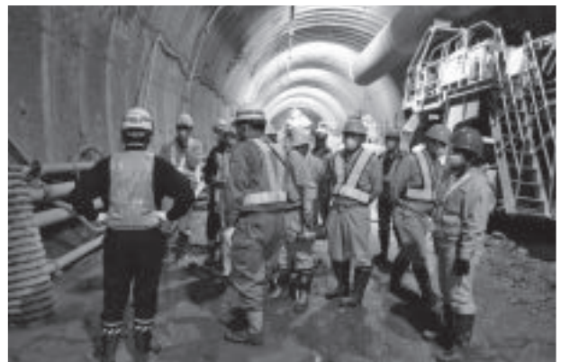
写真-1 現場状況(奥が切羽一森・八雲側)
