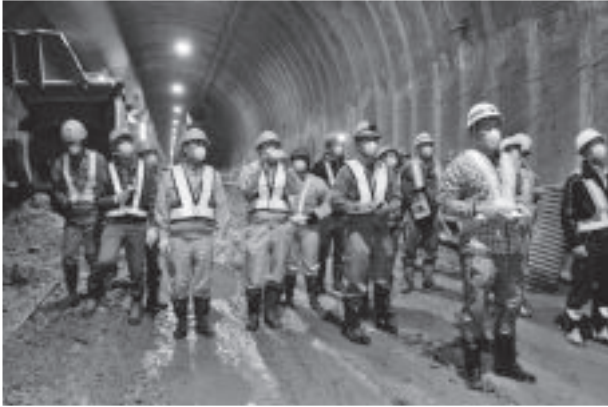
写真-2 現場状況(奥が坑口一函館側)
