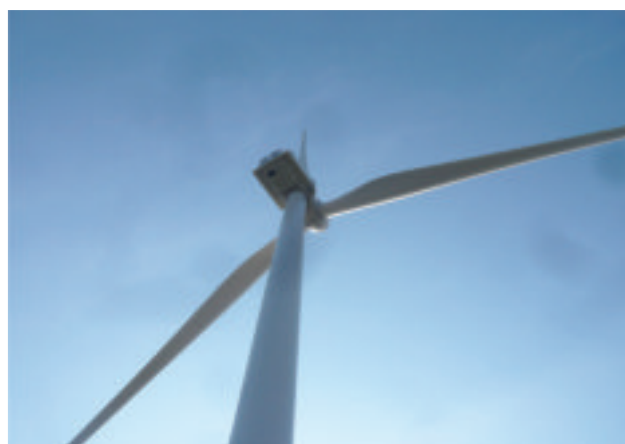
風力発電機のブレード・ハブ・タワー部の様子
