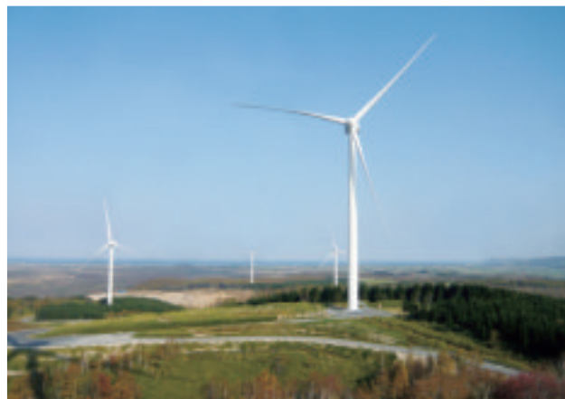
現地視察の天北ウインドファームの全景
