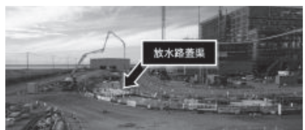
写真-1 タービン建屋(上)および放水路蓋渠(下)
