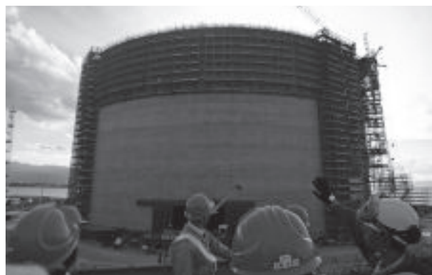
写真-4 No.3LNG 貯槽
