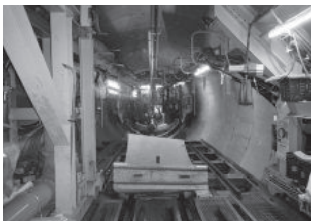
写真-2 トンネル先端部(泥水式シールドマシン)
