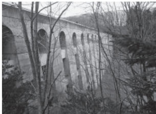
写真1 右岸側からみた笹流ダム
