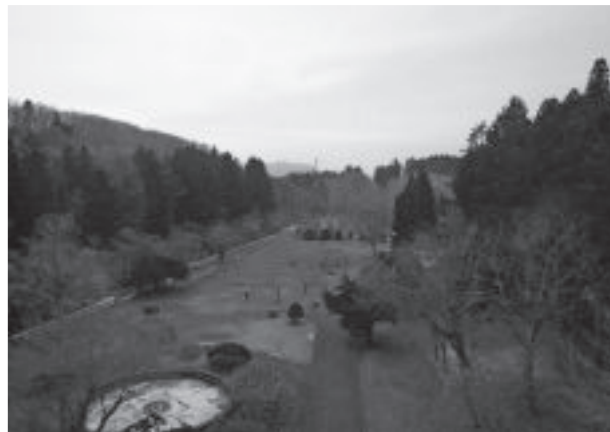
写真2 ダム堤頂より下流側
