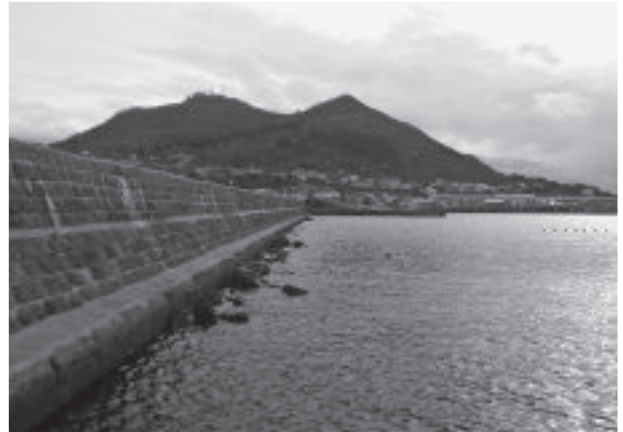
写真 4 複合構造の防波堤
