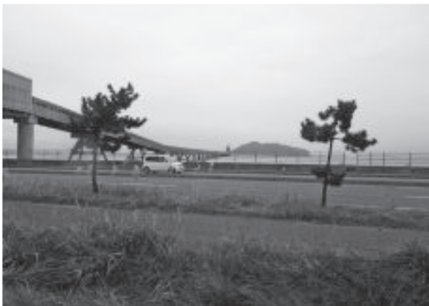
写真 3 上磯工場の栈橋
