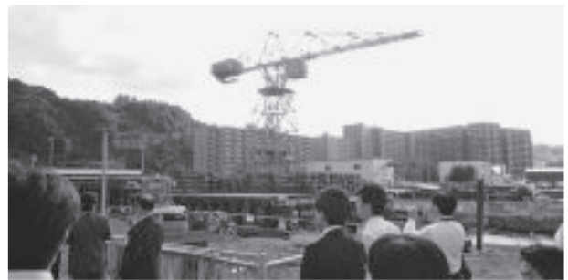
写真-2 斜路式ケーソン製作ヤードとクレーン
