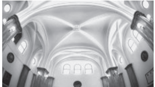
写真-2 吹き抜け天井(アインシュタインドーム)
