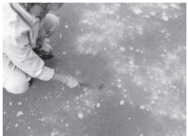
写真-4 CSG の強度確認(手ハンマー)
