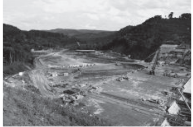
写真-3 サンプルダム建設現場全景
