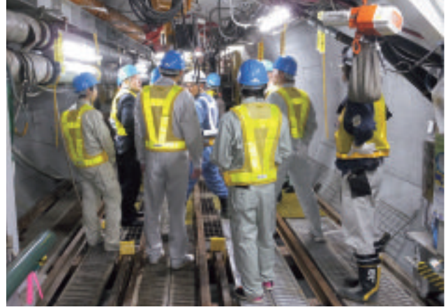
放水路トンネル内部 シールド掘進の内容等の説明を受ける参加者
