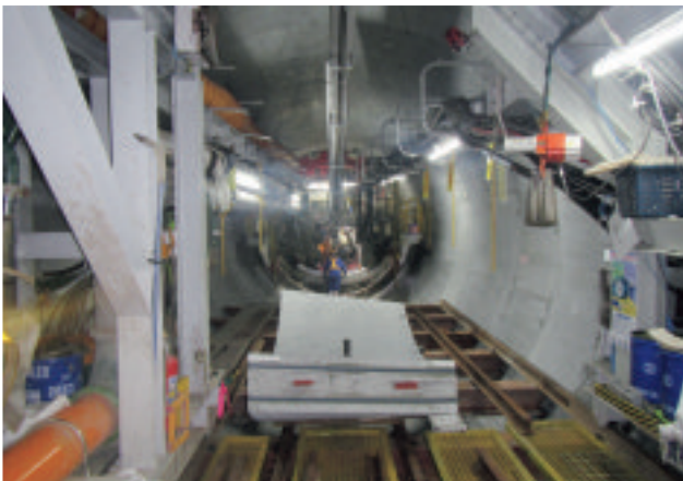
放水路トンネル内部 トンネル先端部(泥水式シールドマシン)
