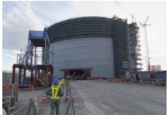
隣接する石狩 LNG 基地建設現場にて建設中の LNG 貯槽 (No.3 LNG 貯槽)
