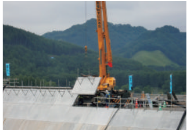
最上部のプレキャスト型枠設置の様子
