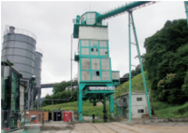
バッチャープラント
