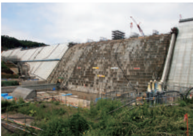
ダム堤体(下流)
