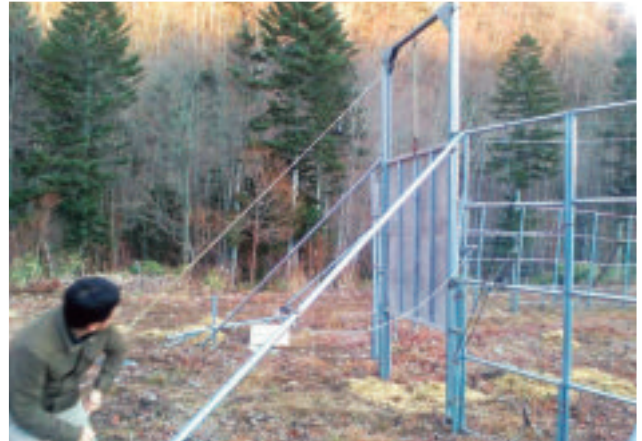
落とし扉落下テスト
