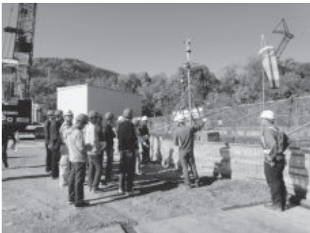
写真 3 新第 1 浄水池施工状況見学
