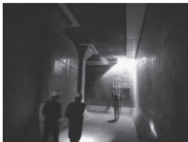
写真 1 平岸配水池内部
