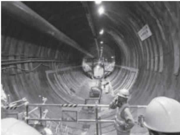
写真-2 トンネル内部(ウォータータイト区間)
