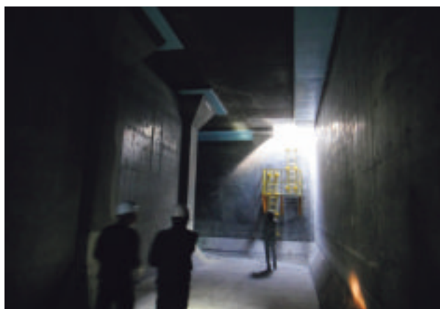
耐震補強が完了した平岸配水地の内部
