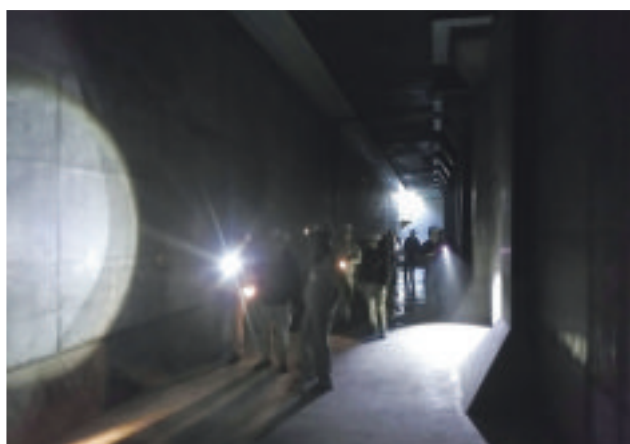
平岸配水地の内部の見学状況
