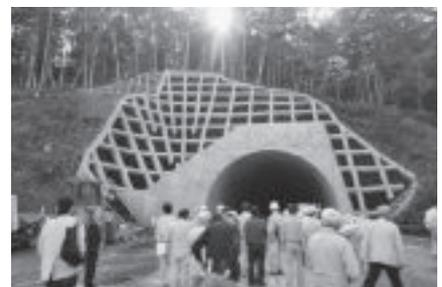
舗装まで完成済みです。車両走行の安全性を高める対策として、トンネル坑口から中に向かって 100m 程度のコンクリート舗装はブラストしてざらざらにしているとの事でした。
