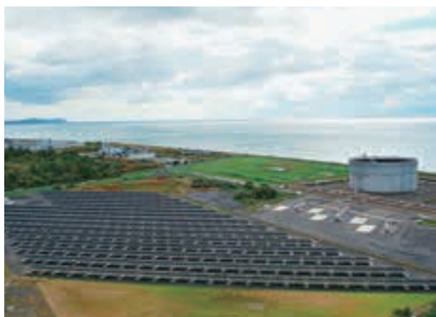
本館屋上から見る伊達ソーラー発電所全景
