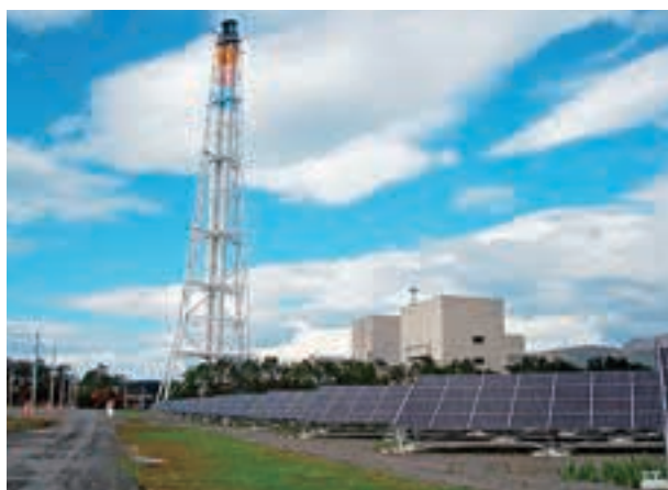
後方は伊達火力発電所
