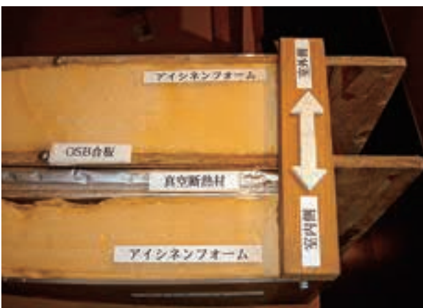
壁・床・天井の断熱構造模型
